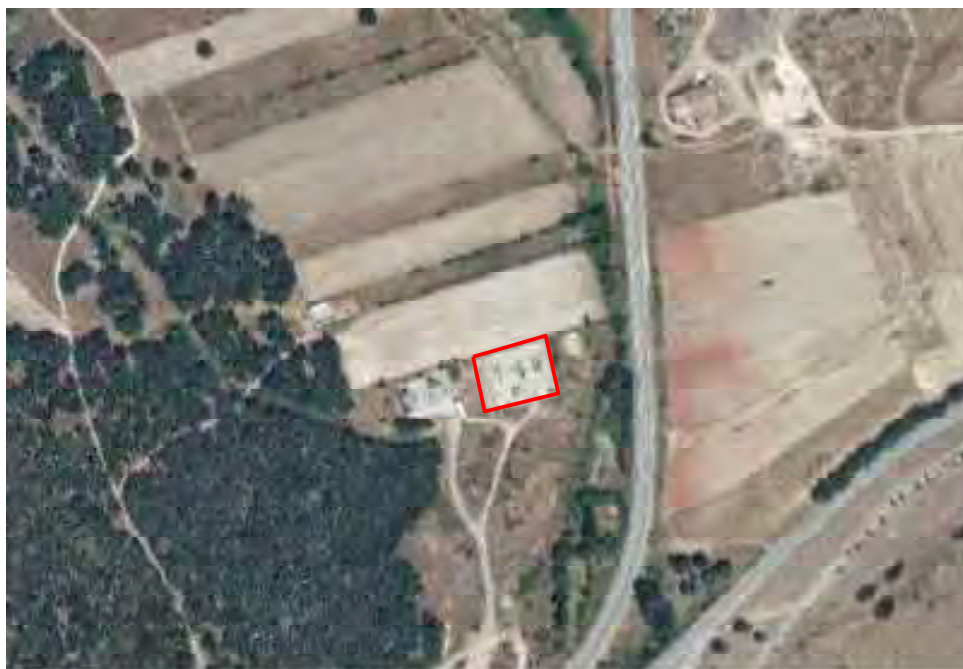
Figura 5. Subestación de Rianza en T.M. de Rianza (inicio de la línea eléctrica en estudio). Fuente: Google Earth
