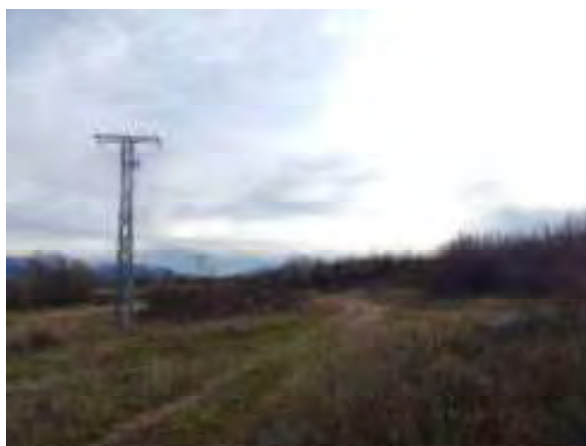
Figura 40. Mezclas de coníferas y frondosas, donde predominan las frondosas, próximas a la subestación de Riaza. Fecha: febrero 2022.
